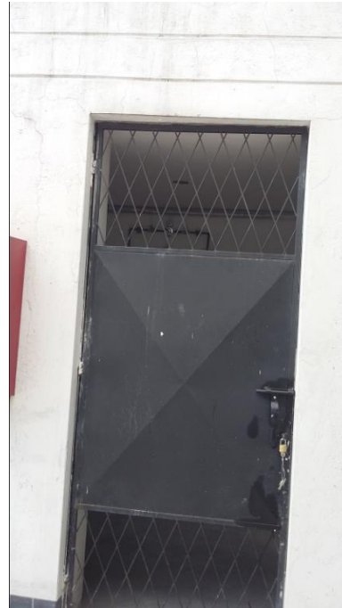
Puerta de ingreso (ventilación)
